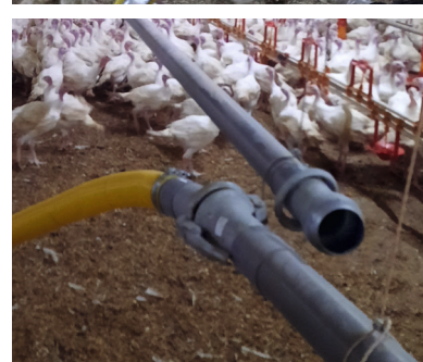
Lorsque l'alimentation dans le bâtiment s'effectue par un tuyau rigide, il faut prévoir plusieurs connexions permettant de couvrir l'ensemble de la surface avec le tuyau souple. ©Euromark
