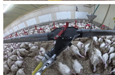
L'utilisation de vannes trois voies facilite le branchement du tuyau souple sans déconnecter le tuyau rigide.
